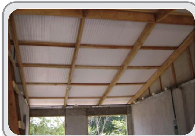
**Detalle de Prodex® instalado sobre apoyo
