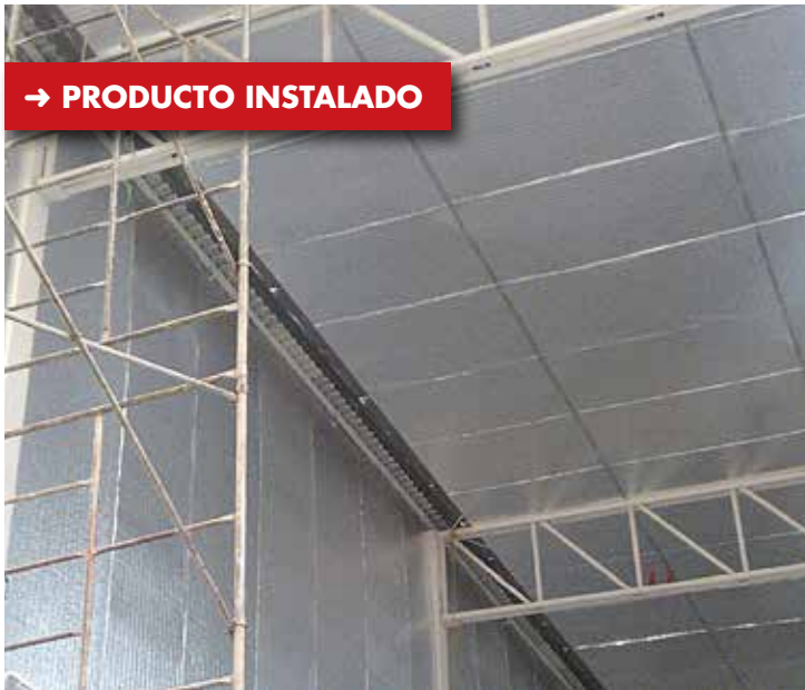
Instalación del AD5
